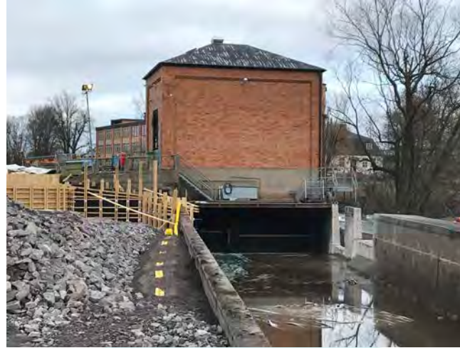
Byggarbetsplatsen på Nykvarnsholmen 2019-03-06
